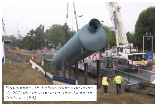
Separadores de hidrocarburos de acero Chatarras Irura (España)
