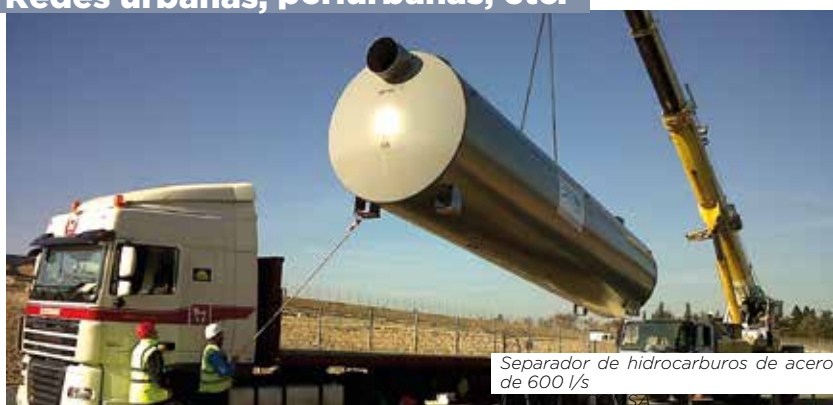
Separadores de hidrocarburos de acero de 200 l/s cerca de la circunvalación de Toulouse (64)
