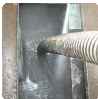
Limpieza de las paredes con lanza de alta presión
