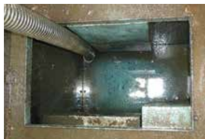
Vaciado de la cámara del separador
