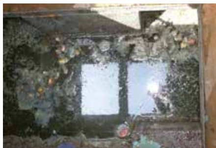
Vista de la cámara de la zona de sedimentación
