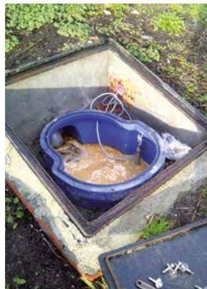
Ejemplo de un separador de grasas antes de vaciarse.
