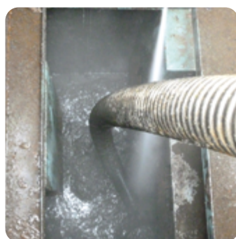
Nettoyage des parois par lance haute-pression
