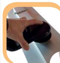
Présenter le siphon et l'insérer jusqu'en butée interne, en respectant l'écart entre la platine du siphon et celle du caniveau.
