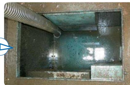
Vaciado de la cámara separadora
