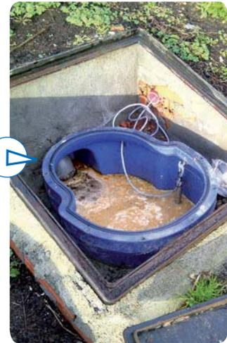
Ejemplo de un separador de grasas que va a ser vaciado
