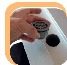
Mettre en place le boîtier de rétention anti-odeurs.
