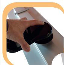
Présenter le siphon et l'insérer jusqu'en butée interne, en respectant l'écart entre la platine du siphon et celle du caniveau.
