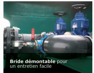
Regard de vannage intégré pour une maintenance aisée
