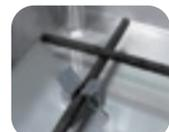
Surélévation du treillis pour faciliter sa prise dans le béton
