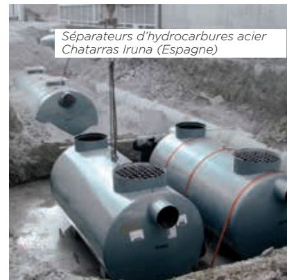
Séparateurs d'hydrocarbures acier 200 l/s à proximité de la rocade de Toulouse (64)
