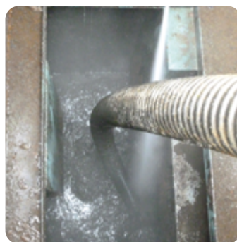
Nettoyage des parois par lance haute-pression
