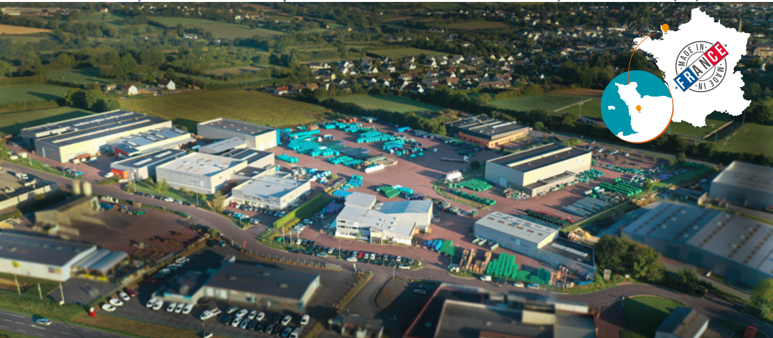
Sur un site industriel de 8 hectares basé à Marigny (50), Techneau a su regrouper toutes les compétences nécessaires à la création, au développement, à la production et à la commercialisation de ses produits.
